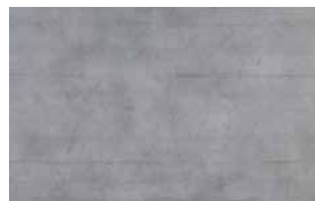
Schalbrete Beton (Abb.)
